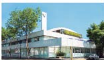
UNIVERMILENIUM PLANTEL TOLUCA AVENIDA HIDALGO
