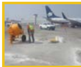
Aeropuerto Internacional de México, Benito Juárez: Sello de juntas y reparación de desconchamientos en elementos de concreto hidráulico y obras complementarias.
