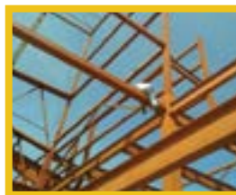
Auditorio Cultural "Wenceslao": Fabricación de su estructura metálica.
