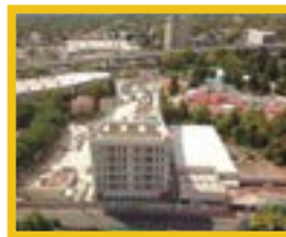
Hotel Galería Plaza San Jerónimo: Excavación y cimentación superficial, construcción de salón para eventos.
