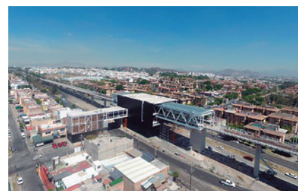
Foto: Infraestructura elevada de la Línea 3 de Guadalajara.
