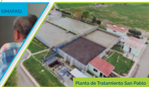
Planta de Tratamiento San Pablo
