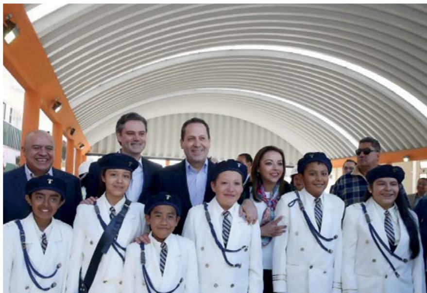
Gobernador del Estado de México, Erviel Ávila, y el Secretario de Educación Pública, Aurelia Nuño, supervisando las obras de remodelación de la primaria José María Morelos y Pavón.
